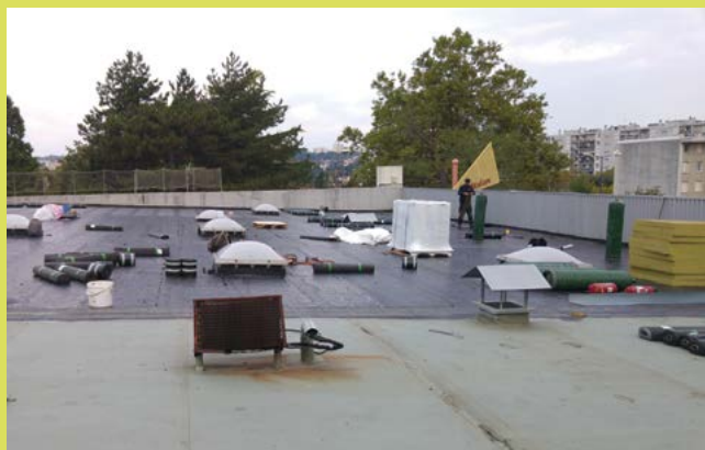
Le toit de l'ancien Atelier en cours de rénovation
