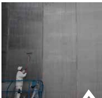
Une peinture imperméabilisante est posée sur le béton brut
