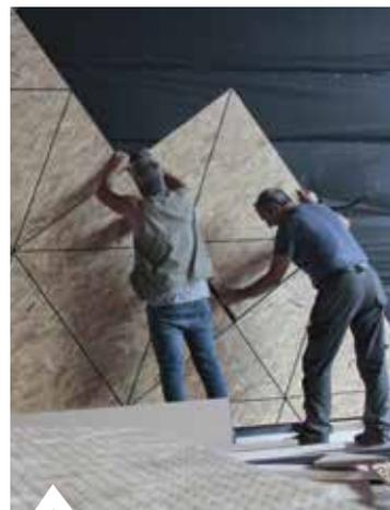
Les panneaux d'isolant phonique sont installés dans la petite salle
